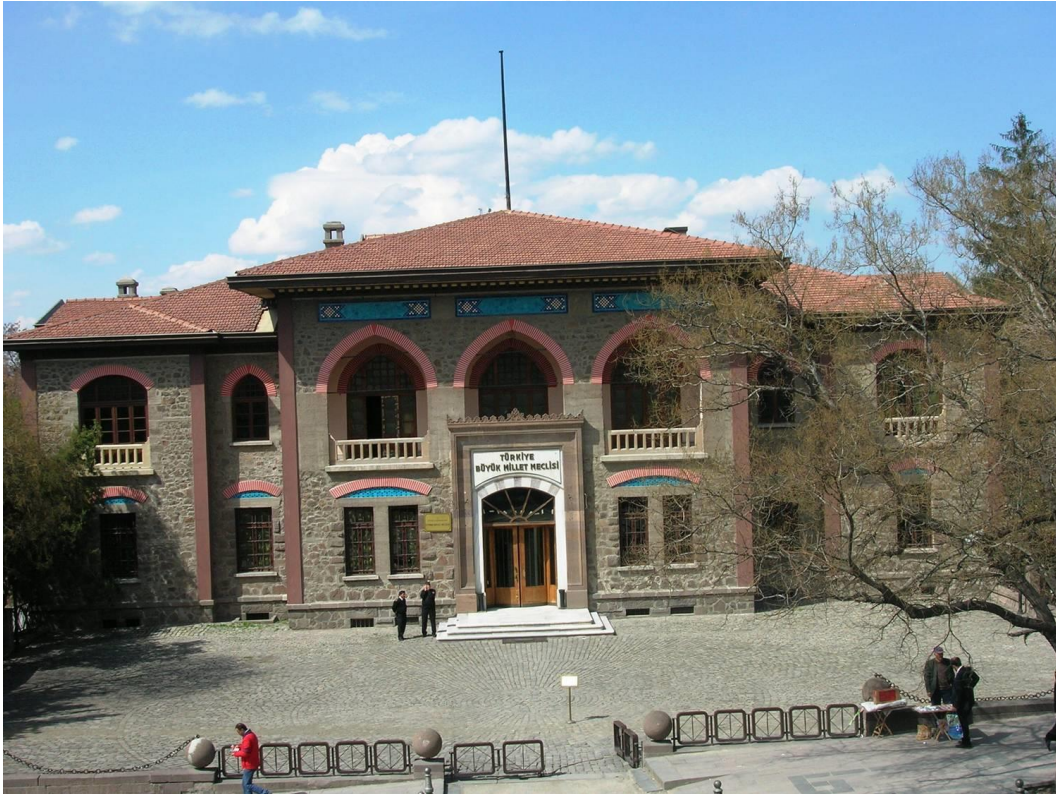
Halk Fırkası Mahvili (II. Meclis Binası) 1924, Vedat Tek, (Foto. M. Çeken)
