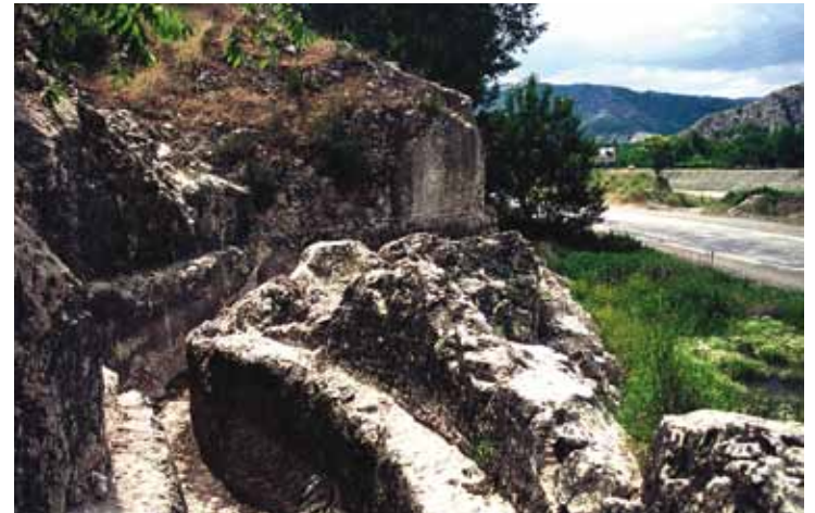
Ferhat Su Kanalı
