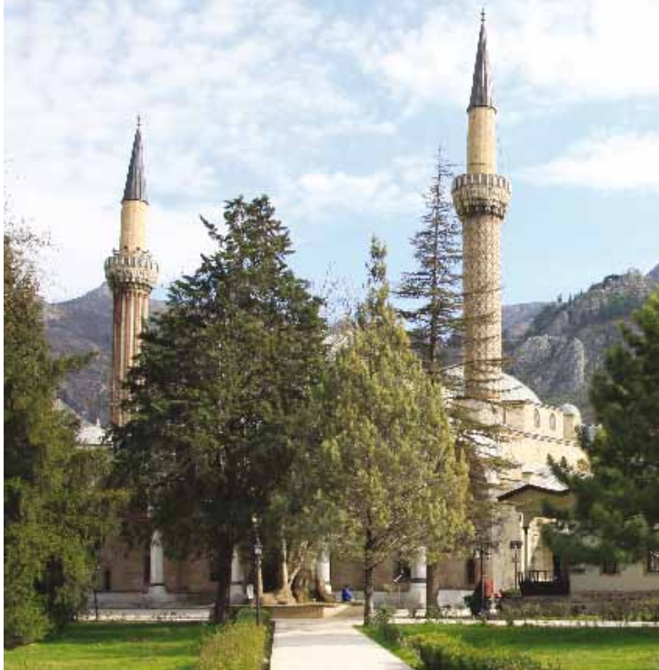
II. Bayezid Külliyesi
